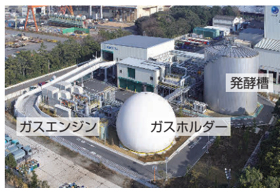
(株)Jバイオフードリサイクル横浜工場
