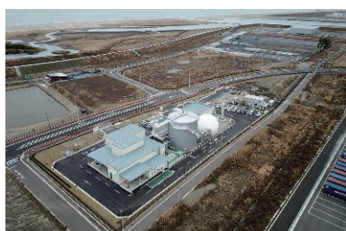
(株)東北バイオフードリサイクル仙台工場
