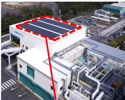
設置屋根面積 **504m<sup>2</sup>** 発電能力 **40kW**
